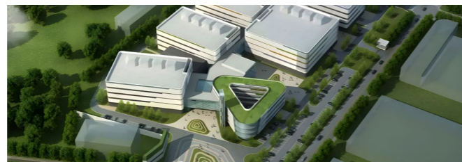
富春云三大数据中心： 1. 杭州富阳数据中心 2. 北京四季青数据中心 3. 杭州大江东富春云数据中心
